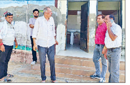
लोहारू। स्वर्ण जयंती पार्क में शौचालय का निरीक्षण करते हुए नगरपालिका के अधिकारीगण। फोटो : हरिभूमि
